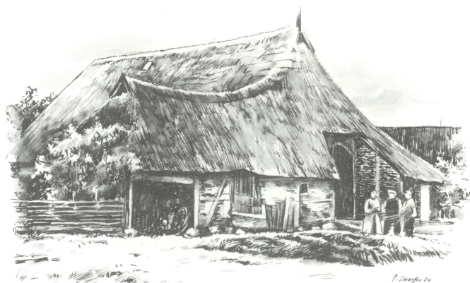
Das ehemalige Haus der Familie Gebert in Dassendorf, früher am Hohlweg gelegen.
