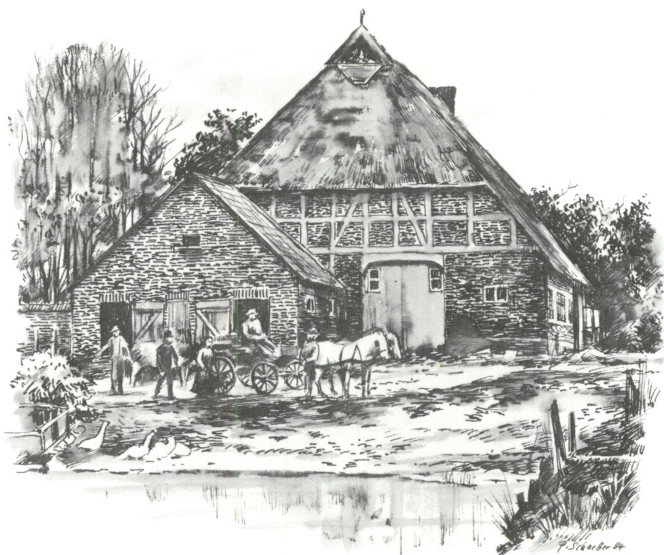
Der Marr'sehe Hof an der B 207 in Dassendorf, früher die Bauernvogtstelle und Pferdewechselstation der Post um 1905
